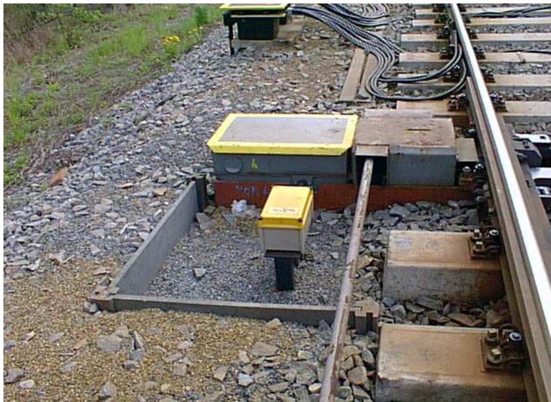
Žlabový prahce s vloženým elektrickým přestavníkem
