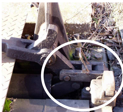
Samovratný přestavník (zapnutý do samovratné činnosti)
