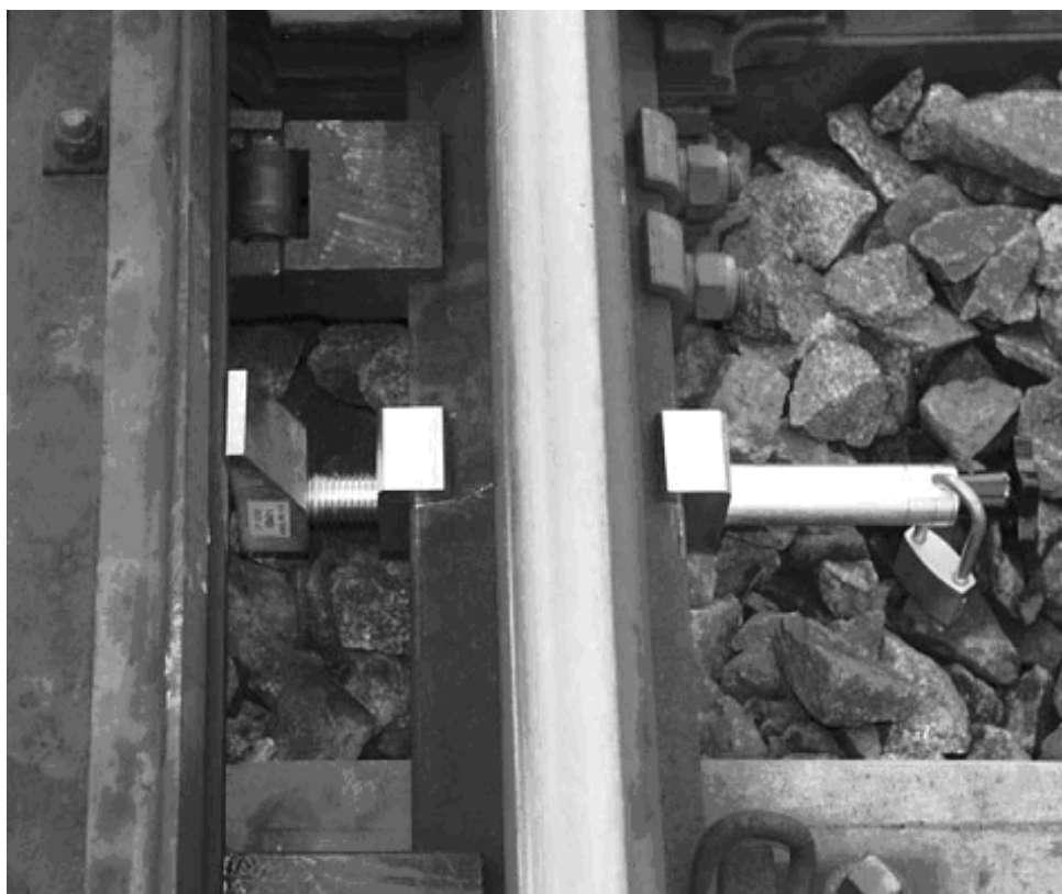
Přenosný odtlačný zámek v zajišťovací poloze
