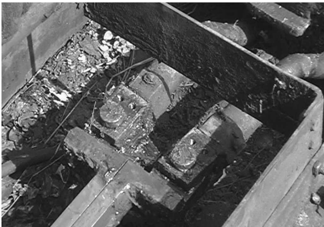
Připojení závorníkových spojnic před vyjmutím spojovacích čepů
