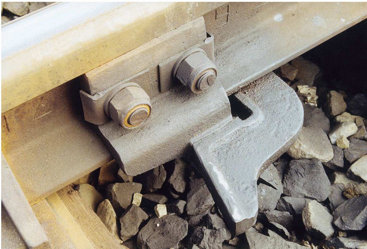
Hákový závěr – úplné zaklesnutí závěrového háku
