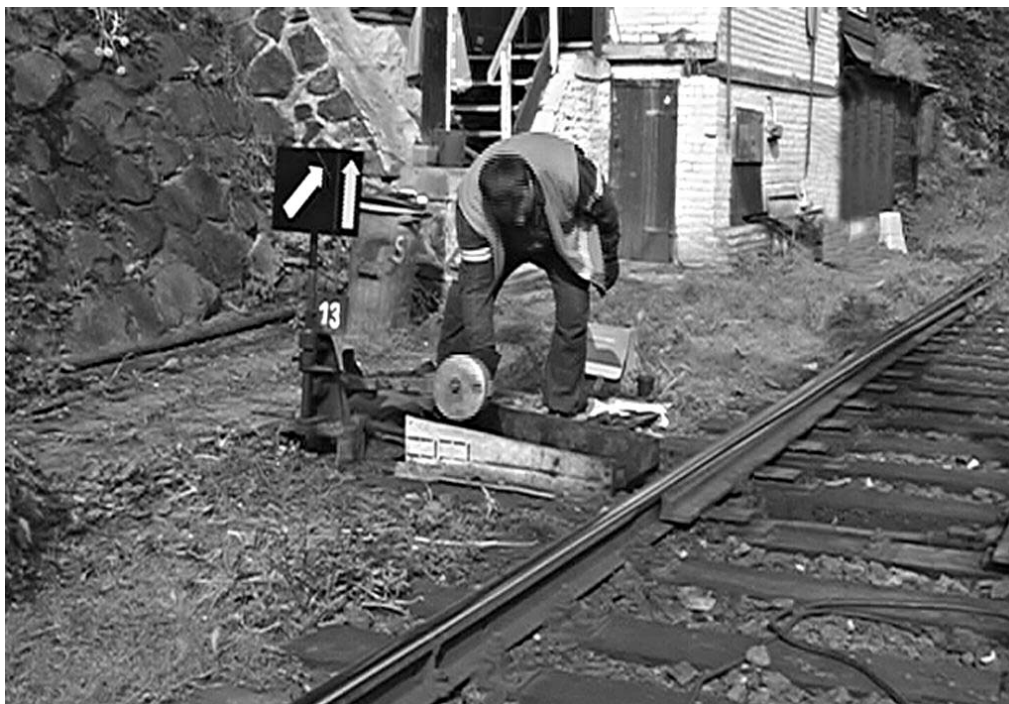
Koncová poloha páky se závažím po provedené úpravě podpěrné vidlice
