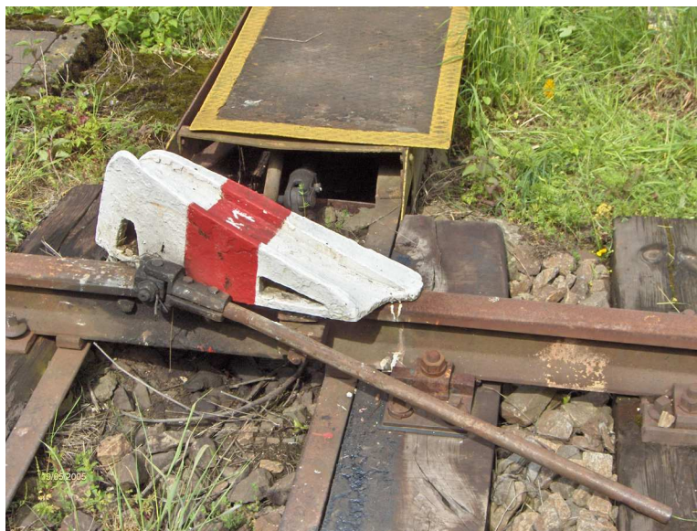
Výkolejka se závěrnou tyčí přestavovaná ručně spojená s mechanickým závorníkem
