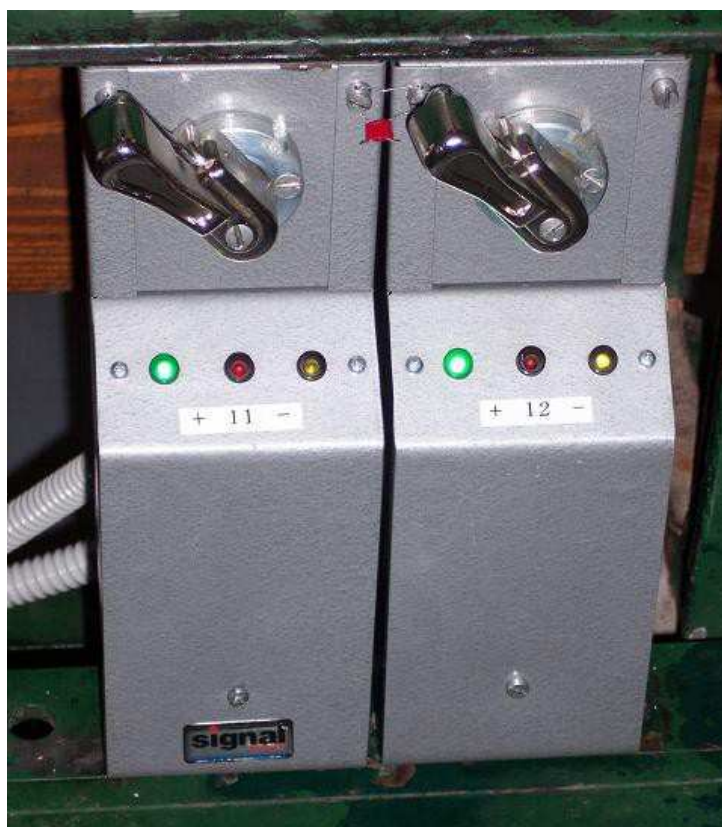
Výhybkový manipulátor - novější provedení
