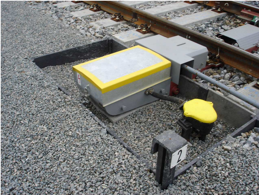
Přírubový žlabový pražec s přírubovým elektrickým přestavníkem
