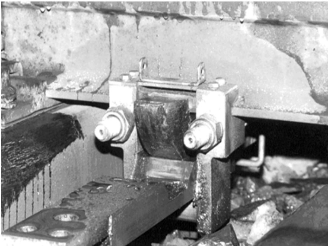
Čelistový závěr - nominální podepření závěrového háku
