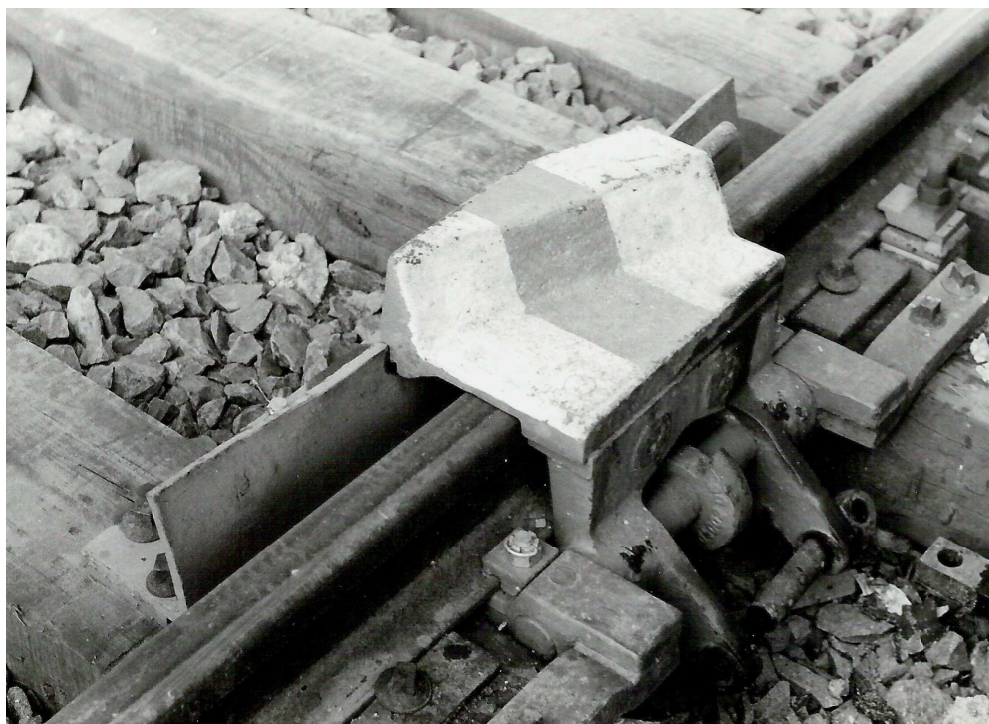
Výkolejka vypnutá z ústředního přestavování
