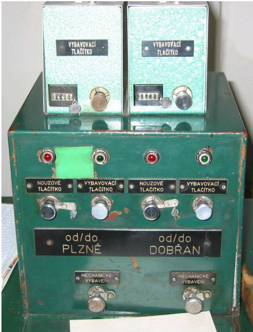
Samočinný závěr výměn – reléový vybavovač
